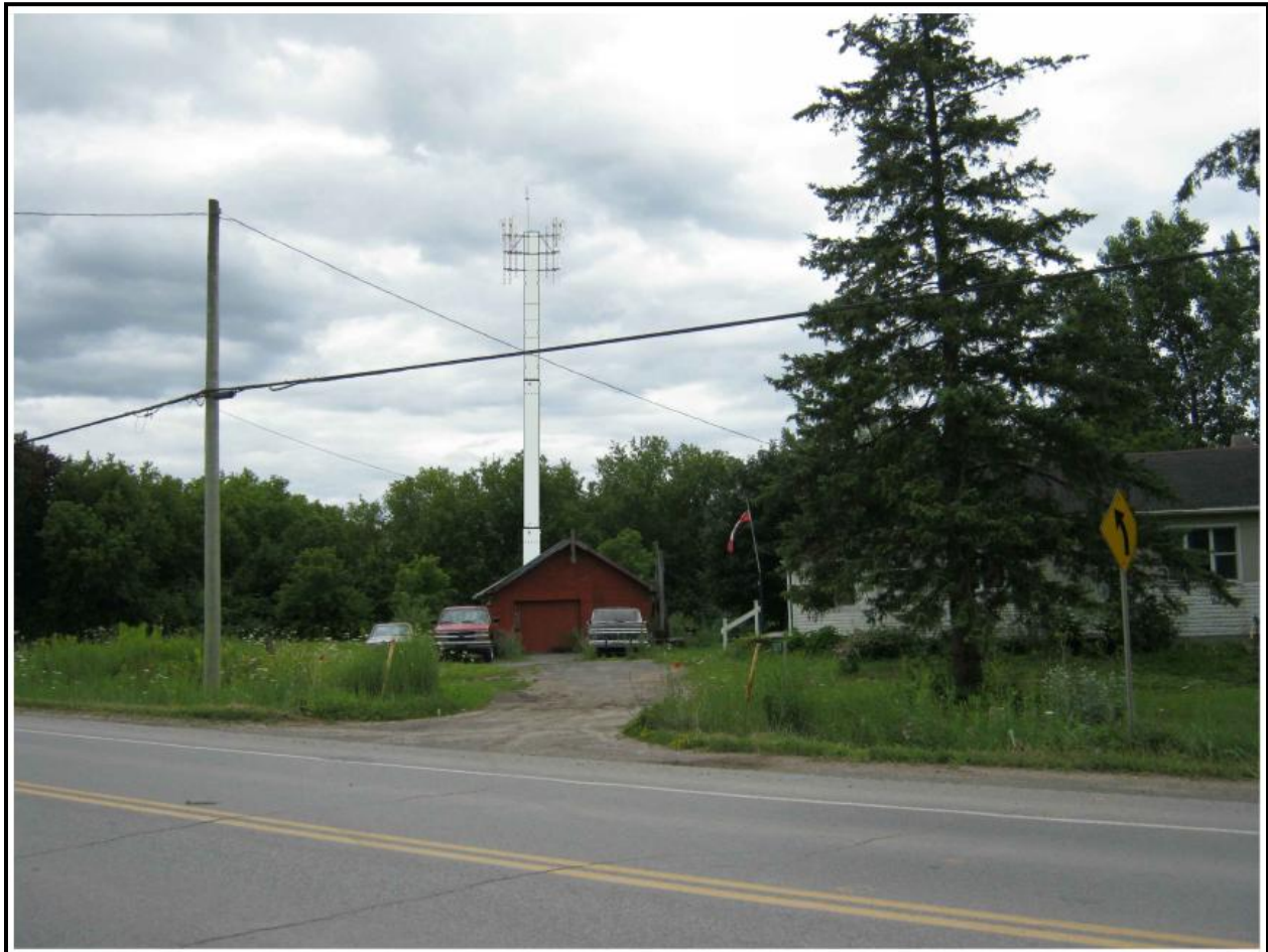
Image taken from Navan Road, with simulation of proposed monopole antenna system. Prise de vue à partir chemin Navan, avec simulation du système d'antennes proposé.
